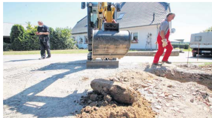
Geschafft. Die entschärfte Bombe ist aus dem Boden geholt. Ein Bagger hat geholfen.
